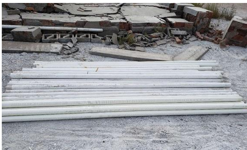
图 6-6 本项目使用井管与滤水管
