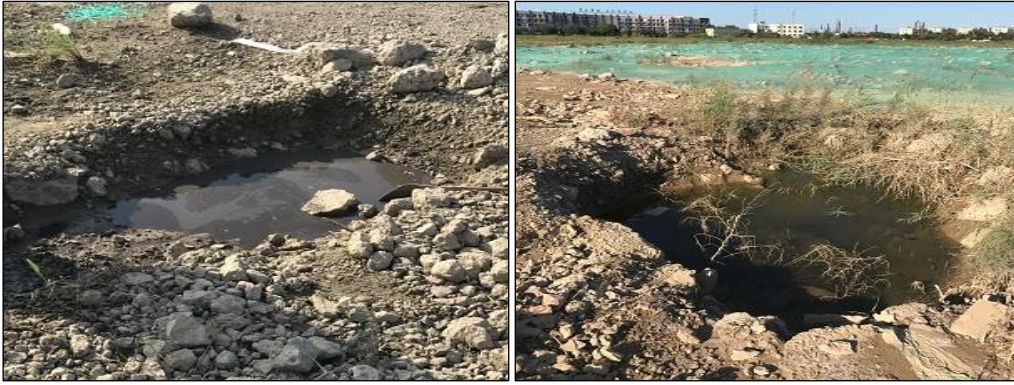
图 2-11 场地内小面积积水坑
